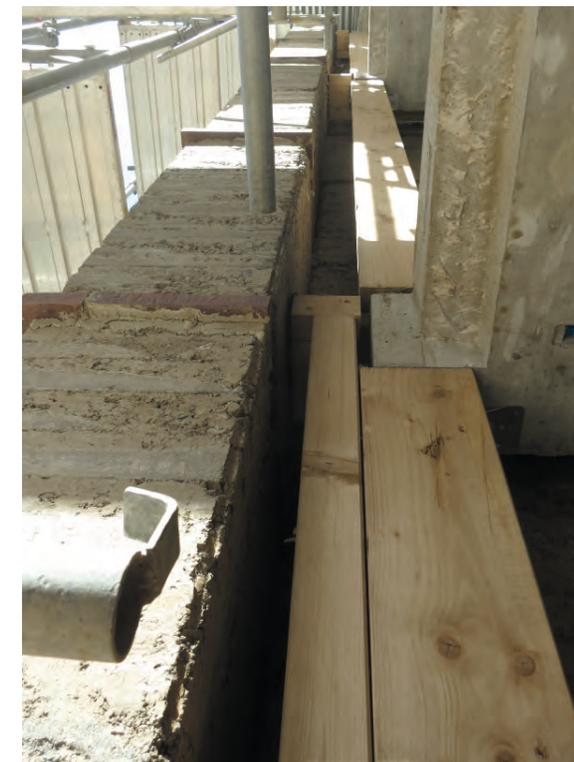
Die Mischkonstruktion aus Lehm, Holz, Beton und Stahl erhielt innenseitig teilweise noch eine Stampflehm-Vorsatzschale oder Lehmplatten mit Kalk- und Lehmputzen.
