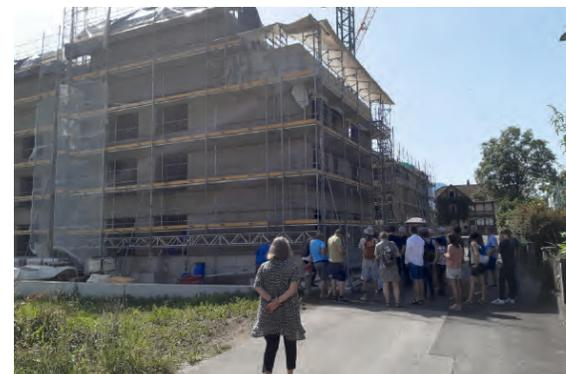
In Buchs wuchs ein vierstöckiges Wohngebäude mit selbsttragenden Stampflehm-Elementen als Aussenwände, frisch aus der ERDEN-Werkhalle in die Höhe. Die Stampflehmwand aus Vorarlberger Flysch und gelblichem Lehm aus Sennwald ist mit Ziegelleisten als Erosionsbremse versehen und die Fenster übernehmen geschickt die Vermittlerrolle unterschiedlicher Setzungen zwischen wirkmächtiger Hülle und holziger Sekundärstruktur für die Dämmung.
