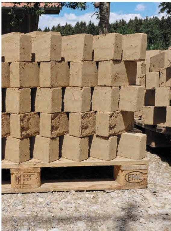
Für den Ersatzneubau eines Bauernhauses wurden aus lokalem Aushub mit einer hydraulischen Lehmsteinpresse 6000 Lehmsteine von der Bauherrschaft geformt und vermauert. Sowohl die inneren als auch die äusseren Riegelwände wurden damit ausgemauert und ersetzen den lehmigen Flechtwerkbewurf des Vorgängerbaus. Aussen wurde der Lehmgrundputz angeritzt und mit Sumpfkalk verputzt, im Tenn
