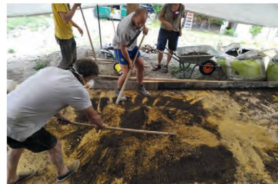
Hoch oben in den Bergen wurde zwar Lehm entdeckt, musste aber noch mit Lehmpulver zur besserer Bindekraft verholphen werden. So konnte er von den emsigen Lehmbauaktiven in die Schalung, die eine ganz gleitend, die andere einseitig fix, rund um die Heizungsleitungen gestampft werden. Die Herausforderung dieser ungewöhnlichen Konstruktion wurde vom Teamgeist eingeholt und so stehen die
