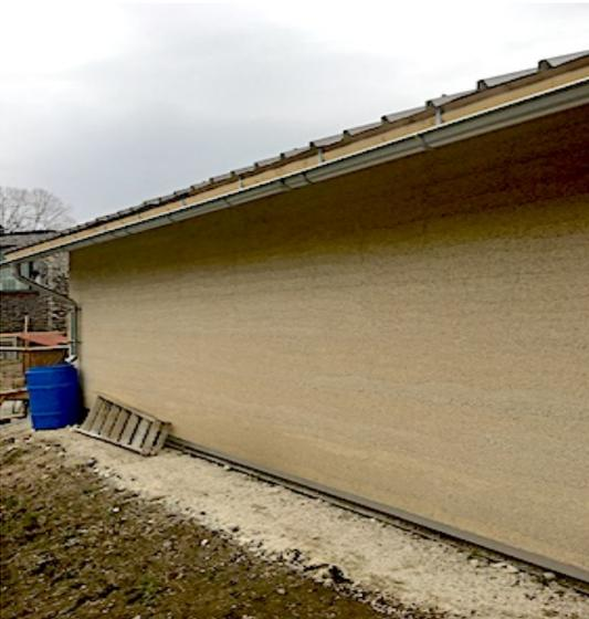
Ein tragender Holzständer wird erstellt und mit einer Gleitschalung eingeschalt. Hanfschäben & Kalk werden gemischt und Schicht für Schicht eingefüllt.
