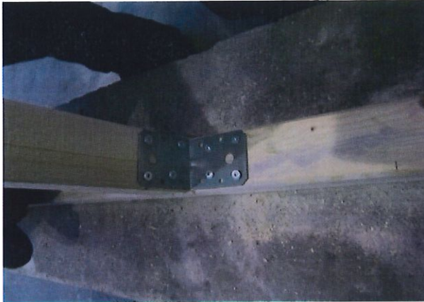
Bild A5.1: Verbindung der Holzständer mit Schwellholz und Rähmholz durch Stahlwinkel 70 mm x 70 mm x 2,0 mm mit Würth Assy 3,0 Schrauben \varnothing 4,5 x 40 mm.
