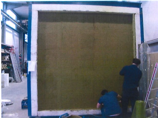
Bild A5.7: Fertigstellung Unterputz „AGATON Lehm Oberputz“ Lehmputzmörtel
