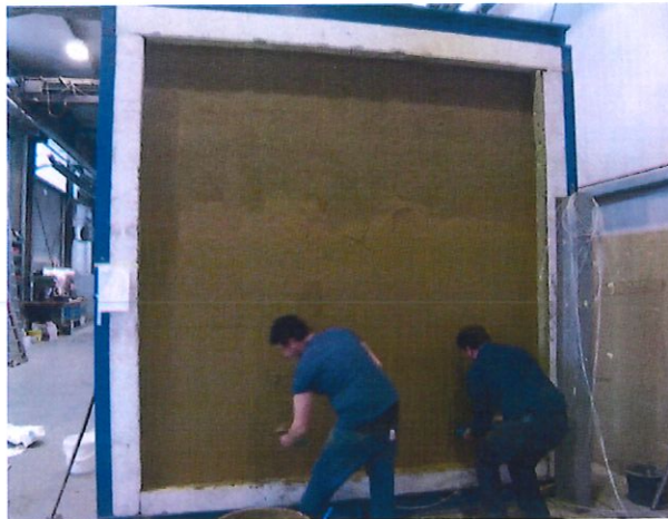
Bild A5.9: Putzauftrag Oberputz „AGATON Lehm Feinputz“ Lehmputzmörtel.
