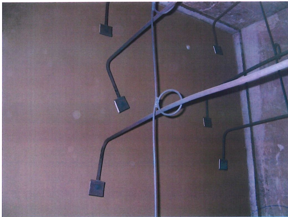
Bild A5.12: Ansicht der Wandkonstruktion zu Beginn der Feuerwiderstandsprüfung.
