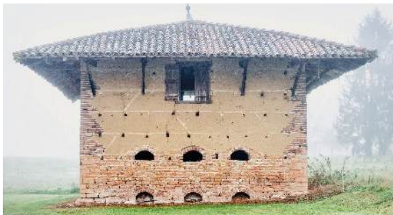
Richtig mit Aushublehm bauen
