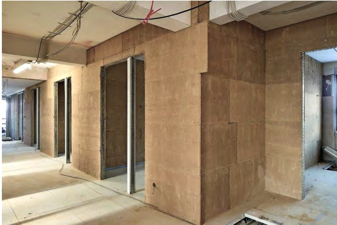
Innenausbau mit Lehmplatten Bild: claytec
