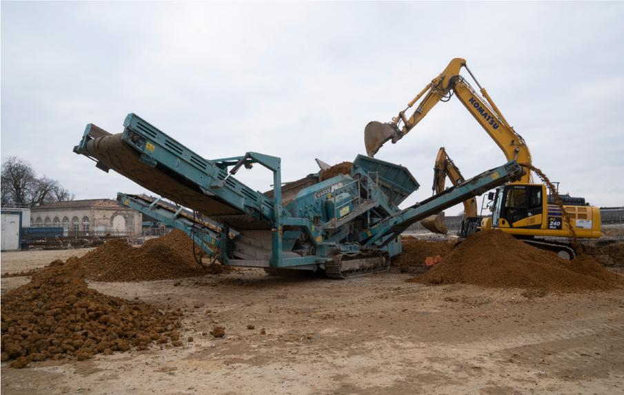
01 Schotteraufbereitungsanlage direkt auf der Baustelle in Bordeaux
