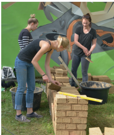
Abb. 1 Mauern mit Lehmsteinen auf dem 1. Tag des ökologischen Bauens an der Hochschule Wismar 2014
