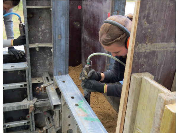
Abb. 5 Verdichten einer Stampflehmwand während der 2. Internationalen Tage des ökologischen Bauens 2015
