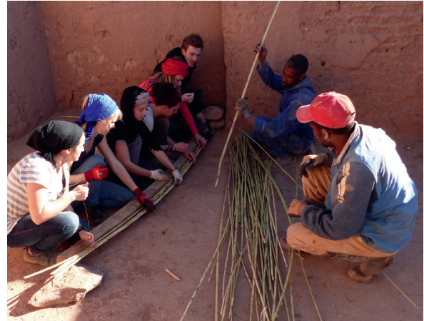
Abb. 8 + 9 Gemeinsame Arbeit und Lernen von Einheimischen: Herstellen einer Leiter aus Bambus auf der Lake Agege Farm in Ghana; Flechten einer Rohrmatte für die Erbneuerung einer Decke in der Kasbah Tamnougalt in Marokko
