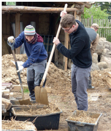
Abb. 2 Mitarbeit auf einer Lehmbau-stelle: Mischen von Mörtel
