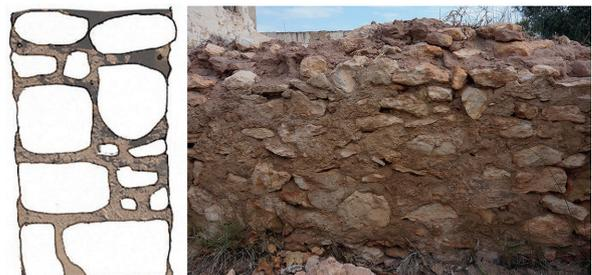
Abb. 8 Detail einer Lehmwand mit Mauerwerkverstärkung
