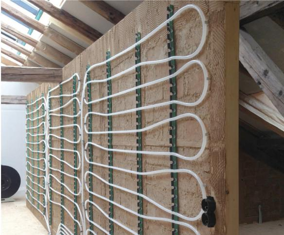
Abb. 11 Holz-Lehm Wand mit Heizungssystem (Torfremise, Schechen)
