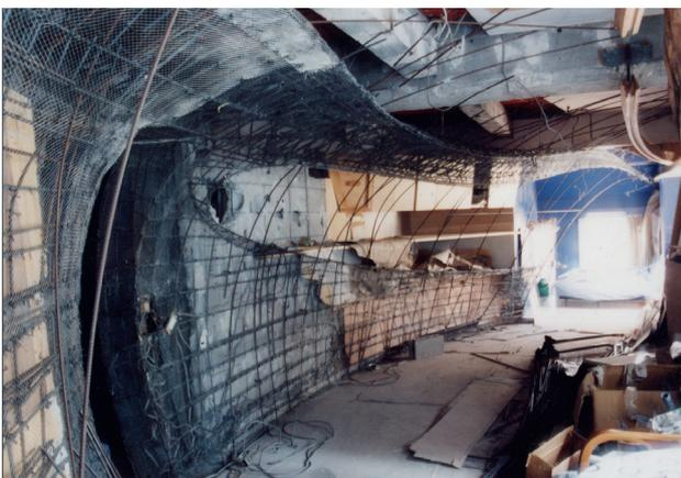
Während der Renovierung – die Lehmwände sind auf geschweißten Stahlprofilen aufgebracht, die zunächst mit Zementmörtel verputzt wurden und dann zweifach mit gelbem und braunen Lehm
