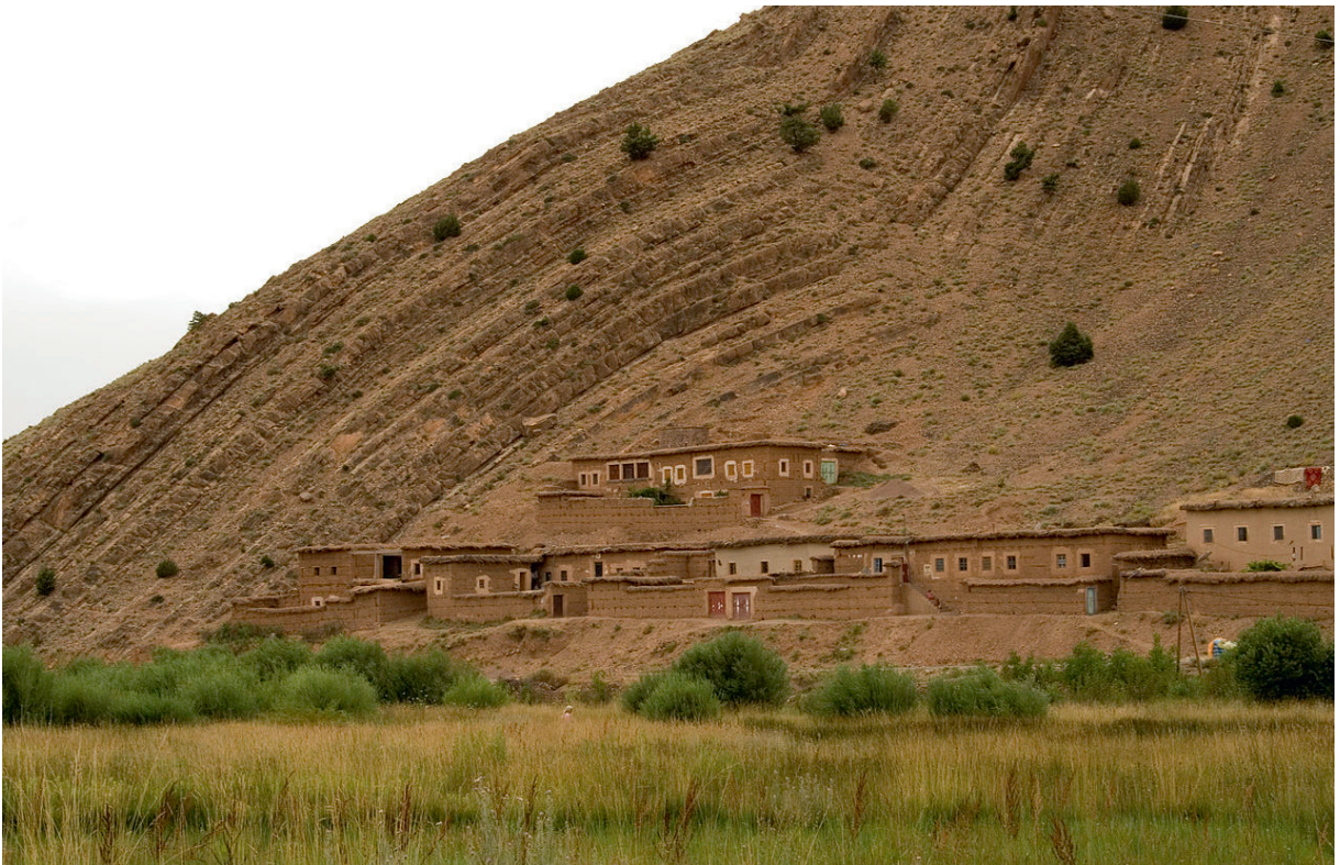
Abb. 23: Dorf Ait Bouguemez, Hoher Atlas, Marokko, Neubau mit lokalem, angepasstem Baustoff Lehm und lokal angepasstem Design
