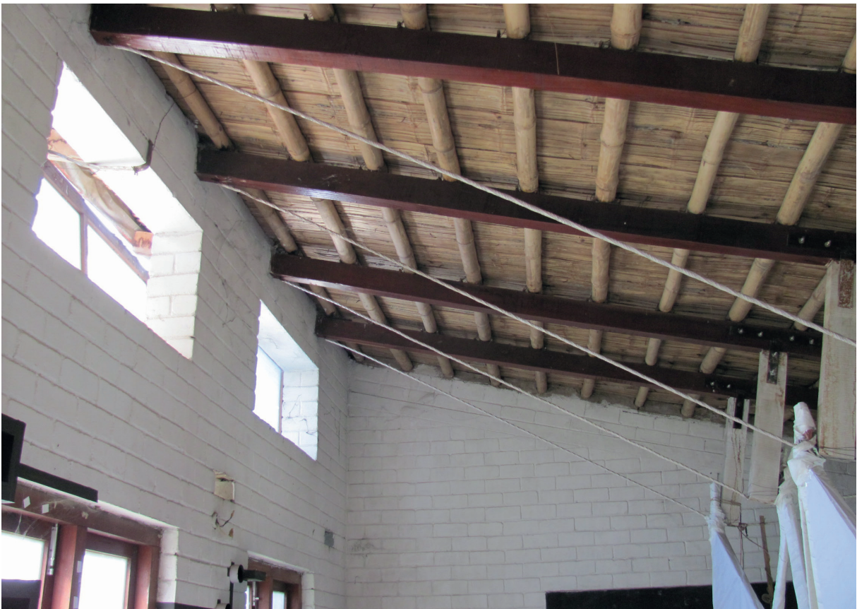
Abb. 11 - 13 Moderne Adaption des Newar-Style im Kathmandutal verbreitet. Modellhaus an der Tribhuvan University Kathmandu mit gepressten Lehmsteinen (hergestellt mit AURAM Steinpressen) und innovativen Konstruktionen zur Ertüchtigung gegen seismische Belastung, unter Leitung von Prof. Dr Sushil B Bajracharya, Associate Professor at Department of Architecture, Planning, Institute of Engineering (IOE), Tribhuvan University (TU)
