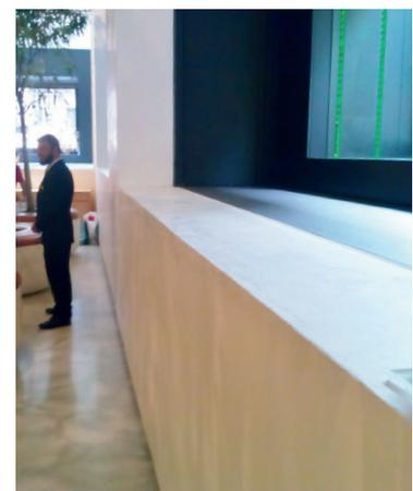
Die Schaufensterbereiche sind mit einem speziellen Weißton aus der YOSIMA®Farbpalette von Claytec verputzt worden. Ausgeführt hat dieses Objekt der Putzerbetrieb Calfe Crimmings, London. Andrew Crimmings hatte zuvor noch nie mit Lehm gearbeitet!
