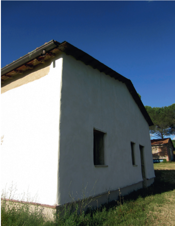
Fig. 6 External lime render
