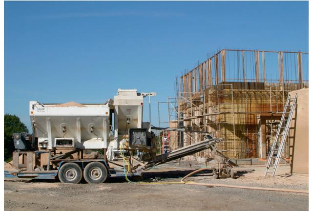
Die zusätzliche Verwendung eines Gabelstaplers mit Füllbehälter erhöht die Effizienz noch mehr. Der Gabelstapler kann das Material transportieren, während der Traktor weiter mischt. Der Lehm wird aus dem Füllbehälter in die Wandschalung eingeschaufelt.
