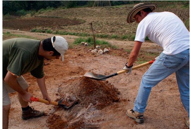
gelieferte Material kann Sand, Kies oder Lehm sein, als Beimischungen zu den lokalen Erden verwendet, um die Festigkeit zu erhöhen oder das Schwinden zu reduzieren. In einigen Fällen ist es am wirtschaftlichsten, alle Baustoffe zu liefern, statt nur lokal verfügbare Erden zu verwenden. Dies hängt von den Kosten und Lieferentfernungen ab.
