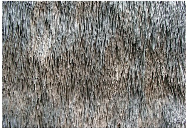
4 Nisterau-Bach: Die Strohschicht an diesem erhaltenen Beispiel zeigt eine Ausführung mit langen und dicken Roggenstrohhalm. Das Stroh wurde entgegen der Anordnung vom 13.09.1822 nicht kurz abgeschnitten. Der dicke Strohpelz schützte das auf der Basalthochfläche des Westerwaldes gelegene Haus Jahrhunderte lang vor der Witterung.
