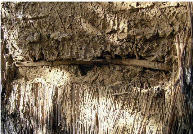
5 Nisterau-Bach: Reparaturarbeiten um 2002 geben Zeugnis einer früheren Reparatur. Zu sehen ist der Einsatz von Zinkdrahtklammern, wohl um 1900-1920. Auch ein Stock ist in den auf dem Fachwerkgefüge aufgebrachten Lehm eingedrückt. Dies belegt eine Ausführung entsprechend der genannten Verordnung.
