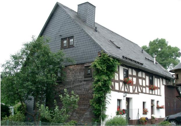
3 „Gefiederte Wand“ in Nisterau-Bach 2006: Bei Sanierungsarbeiten an dieser Fassade waren die handwerklichen Ausführungsarten aus 2 Jahrhunderten ablesbar. Sie belegen den Einsatz von Zinkdrahtklammern aus der Zeit um 1900 –1920 und auch den Einsatz von Holzstöcken, an denen die Strohbindel mit Strohseilen „angenäht“ waren.
