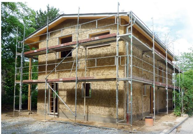
Als kostengünstigste Möglichkeit der Gründung wurde auf Fundamente verzichtet und die Bodenplatte direkt auf eine lastverteilende und gleichzeitig wärmedämmende Glasschaumschotter-schüttung betoniert. Die CAD-unterstützt vorgefertigten Holzrahmen- und Massivholzdeckenelemente wurden innerhalb weniger Tage aufgebaut und das Dach mit großformatigen Faserzement-Wellplatten gedeckt. Im „Holzrohbau“ wurden zunächst Elektro, der Schornstein für den Grundofen und der Warmwasserkollektor installiert.
