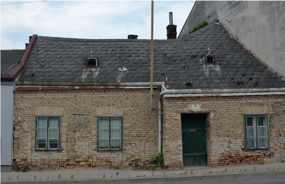
Abb. 8 historisches Mischmauerwerk inmitten des Stadtgefüges von Hollabrunn (NÖ)
