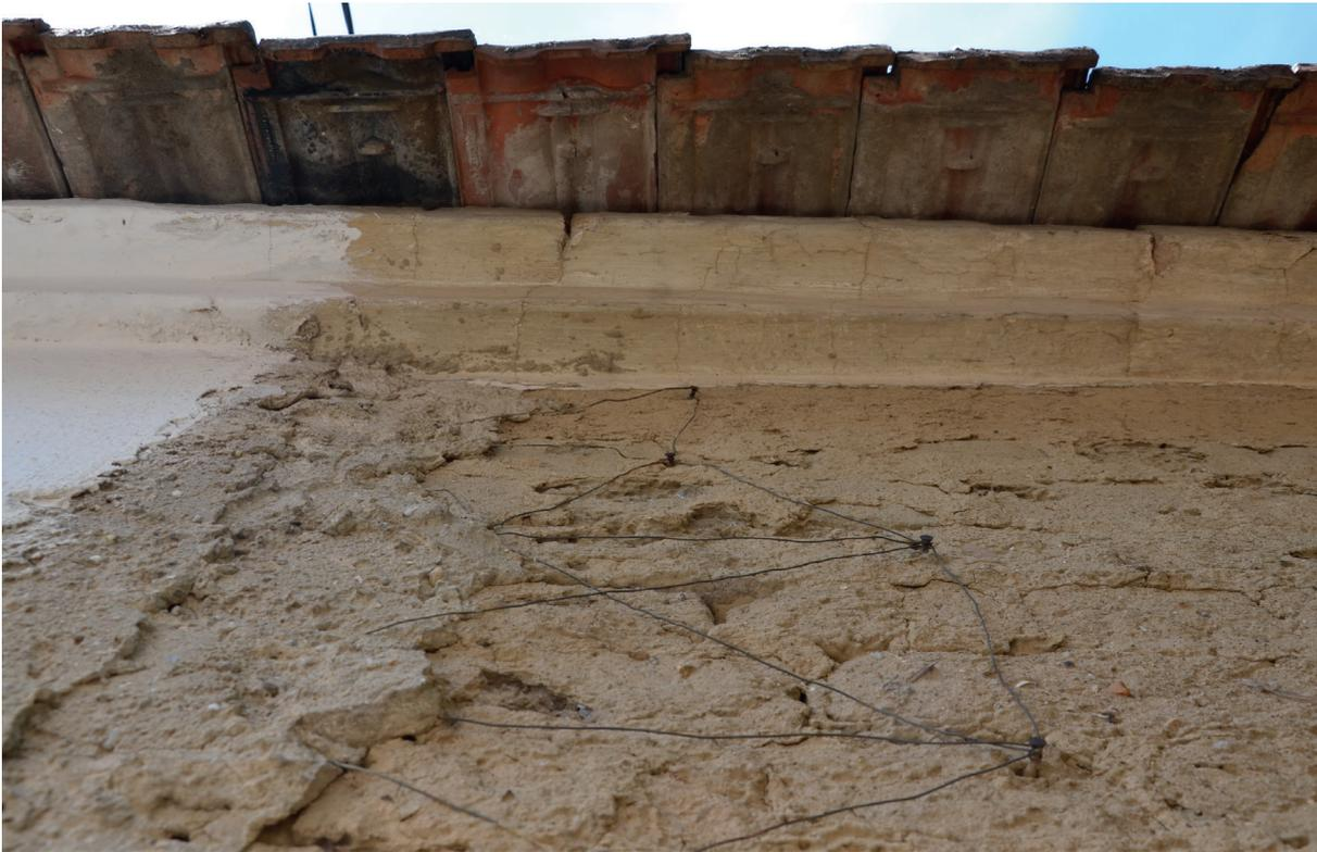
Abb. 3 Außenputzaufbau eines Weinviertler Lehmziegelbaus mit Kalkanstrich
