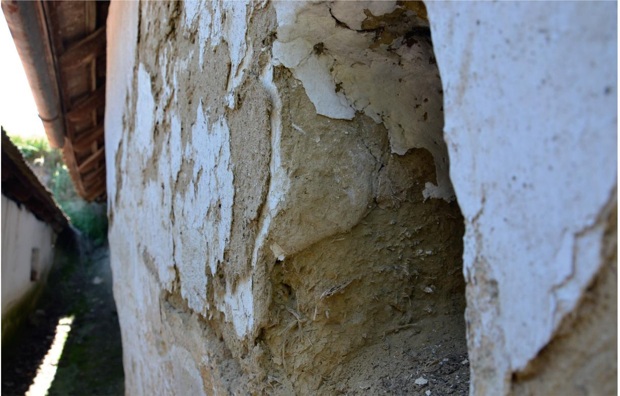
Abb. 4 G'satztes Mauerwerk in Haugsdorf (NÖ)
