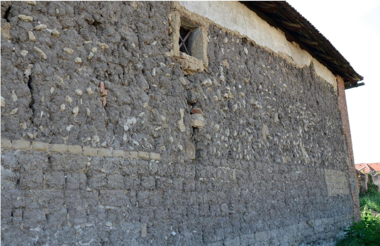
Abb. 5 Wuzelmauerwerk auf Quaderstockmauerwerk in Zellerndorf in NÖ
