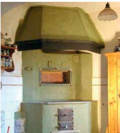
Küchenofen mit Backfach, Stubenofen mit Wärmebank, Praxisräume mit Lehmputz (Lehmbau Beuchel) Kitchen stove with earth cladding, clay oven with air-heated bench, cosmetic studio with clay plaster (Lehmbau Beuchel)
