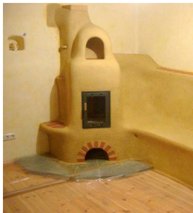
Küchenofen mit Backfach, Stubenofen mit Wärmebank, Praxisräume mit Lehmputz (Lehmbau Beuchel) Kitchen stove with earth cladding, clay oven with air-heated bench, cosmetic studio with clay plaster (Lehmbau Beuchel)
