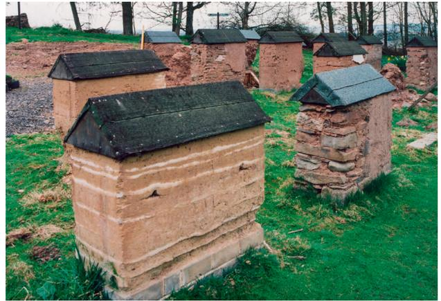
der Lehmbauten. Ihre Dehnbarkeit, Reversibilität und hygroscopische Wechselwirkung mit Wasserdampf macht sie angepasst für eine Verarbeitung mit anderen Materialien und Bauweisen.
