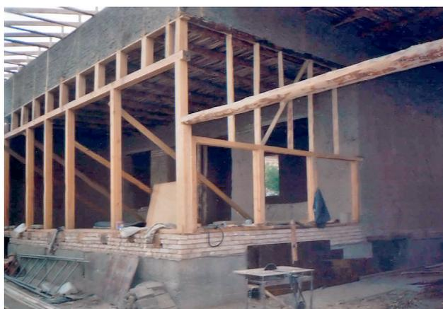
damenten ausgeführt. Die Gebäudeabmessungen betragen: Wandstärken 40-50cm, Grundfläche 14×20m, Geschosshöhe 3,0m, Holzdecken, Dächer aus Asbestzementplatten an den Holzdachsparren befestigt.
