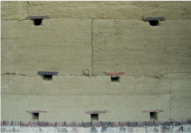
Die Segmentfugen in den Stampflehmwänden bildeten sich planmäßig als Sollrissfugen aus Abb. 6. Es gibt an keiner Stelle über mehrere Segmenthöhen durchlaufende Risse.
