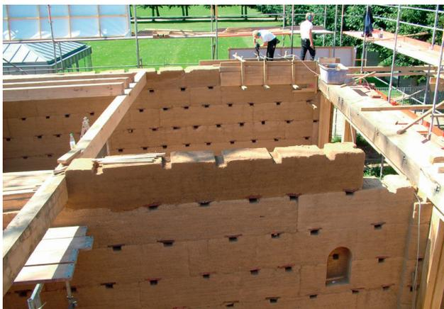
latte angeordnet, um ein Aufreißen innerhalb des Segmentes zu verhindern. Die Schwindfuge sollte sich planmäßig an den Segmentstößen ausbilden. Die Schalung sollte derart ausgebildet werden, dass an der Segmentfuge eine Nut-Feder-Verbindung besteht.
