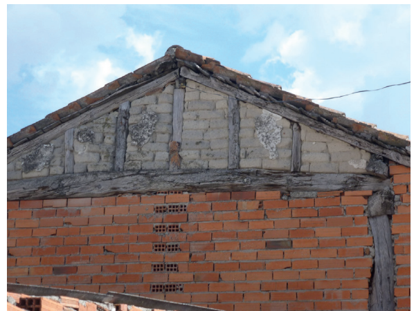
Abb. 1 Wiederholte Eingriffe mit industriell gefertigten Backsteinen bei der Restaurierung von Adobewänden in zwei Häusern in Palencia und Segovia.)
