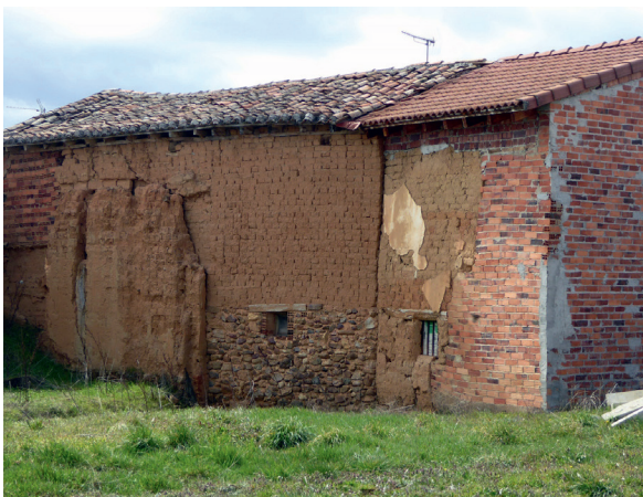
Abb. 1 Wiederholte Eingriffe mit industriell gefertigten Backsteinen bei der Restaurierung von Adobewänden in zwei Häusern in Palencia und Segovia.)
