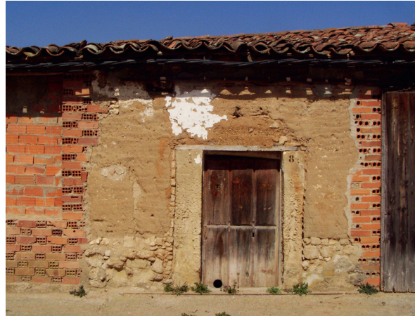
Abb. 2 Unterschiedliche Bauweisen traditioneller Lehmarchitektur. Wohnhaus in Arcediano (Salamanca) mit Wänden aus Stampflehm auf einem Fundament aus Quadersteinen und Lehmballen, repariert mit Hohlziegeln.
