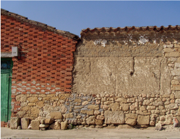
Abb. 2 Unterschiedliche Bauweisen traditioneller Lehmarchitektur. Wohnhaus in Arcediano (Salamanca) mit Wänden aus Stampflehm auf einem Fundament aus Quadersteinen und Lehmballen, repariert mit Hohlziegeln.
