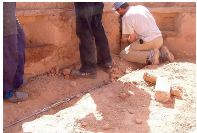
1 Sanierung des Eckturms mit Stahlseilen, Spannschlössern und Ankerplatten
