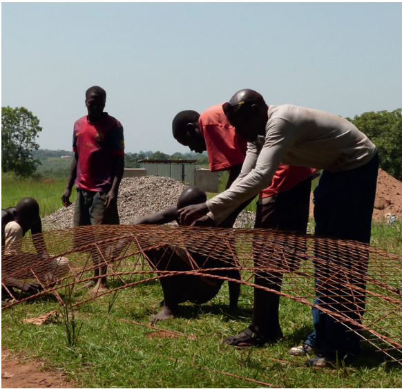
Vorfertigung der Decken-Elemente
