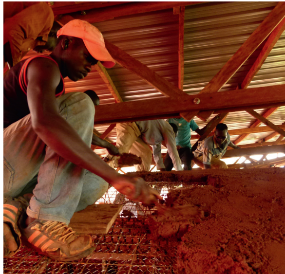
Herstellen des Lehmewurfs auf den Decken-Elementen
